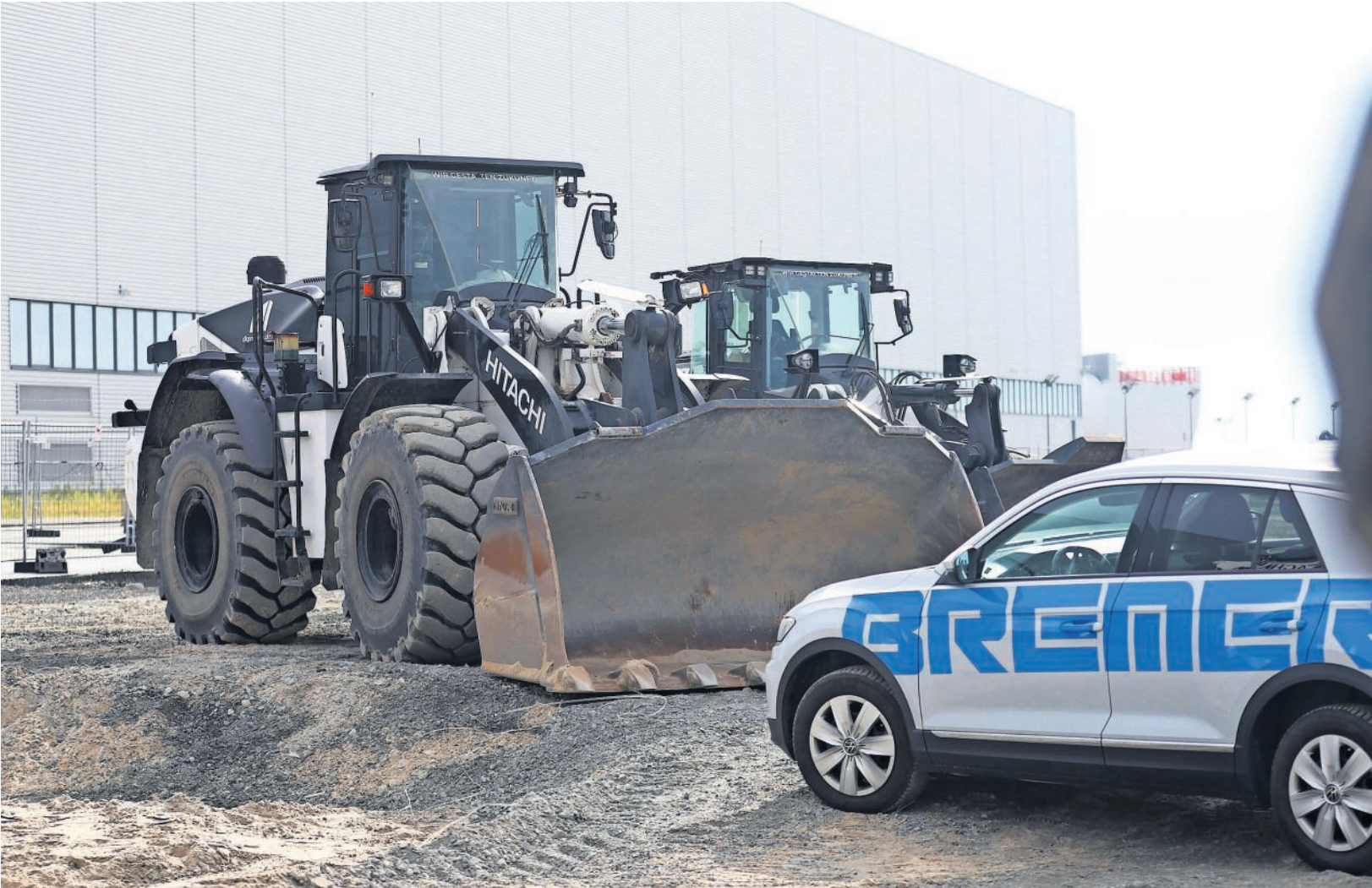
Bagger und Baufahrzeuge auf dem Gelände von Siemens Gamesa in Cuxhaven: Der Spatenstich für die neue Logistikhalle symbolisiert trotz wirtschaftlicher Herausforderungen Optimismus für die Zukunft der Offshore-Windenergie. Fotos: Larschow
